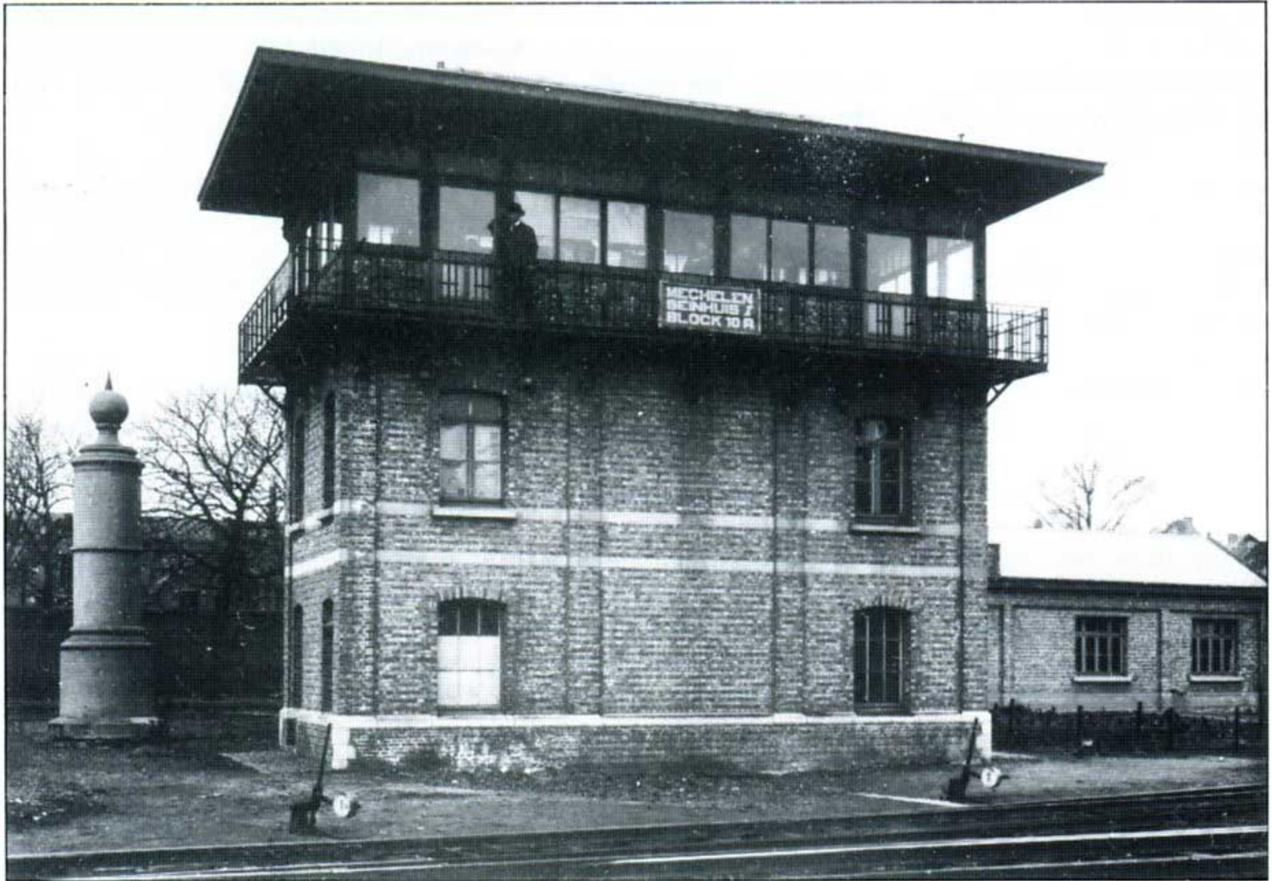
Het elektrische seinhuis.
