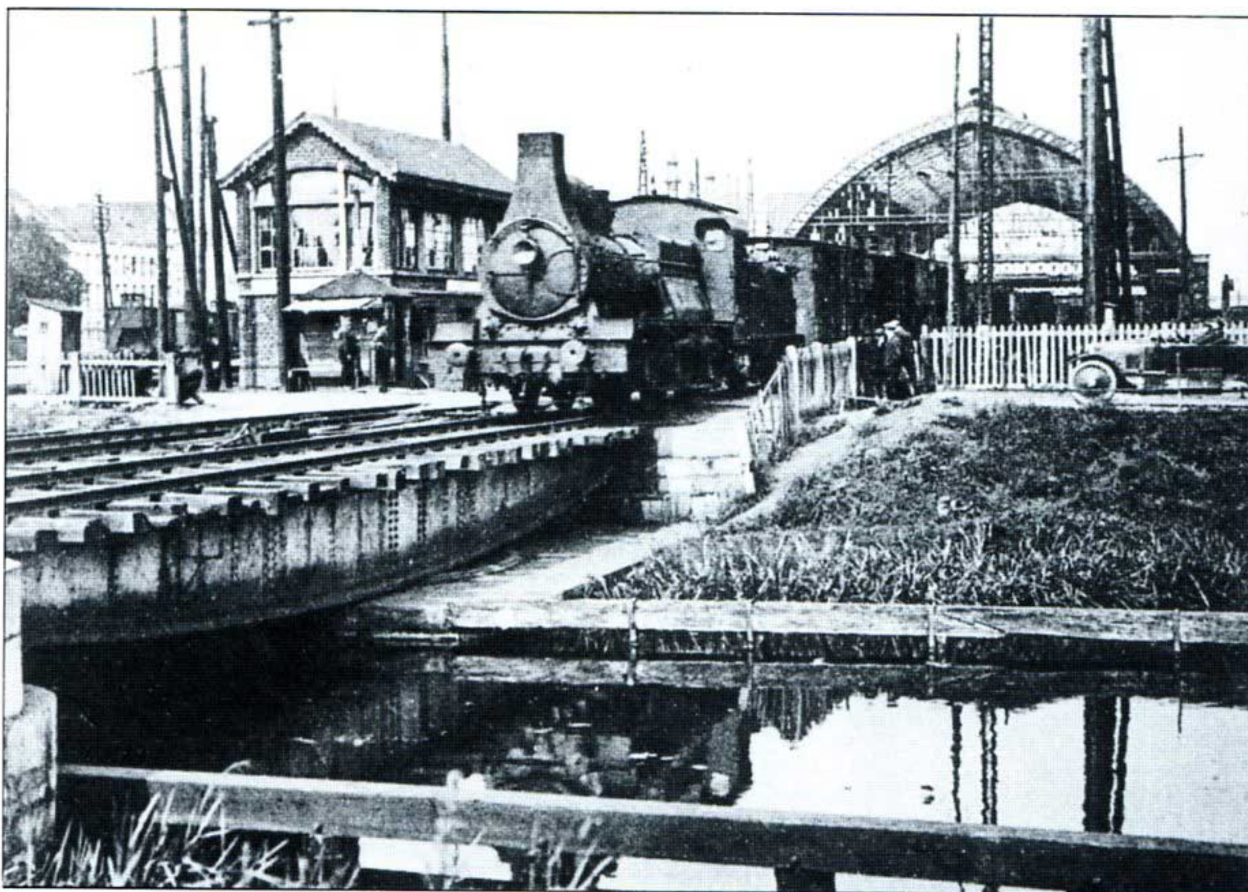
Het herbouwde en vergrote seinhuis. Gebouwd in 1893; gesloopt in 1926. Altijd maar wachten vóór de gesloten overweg!
